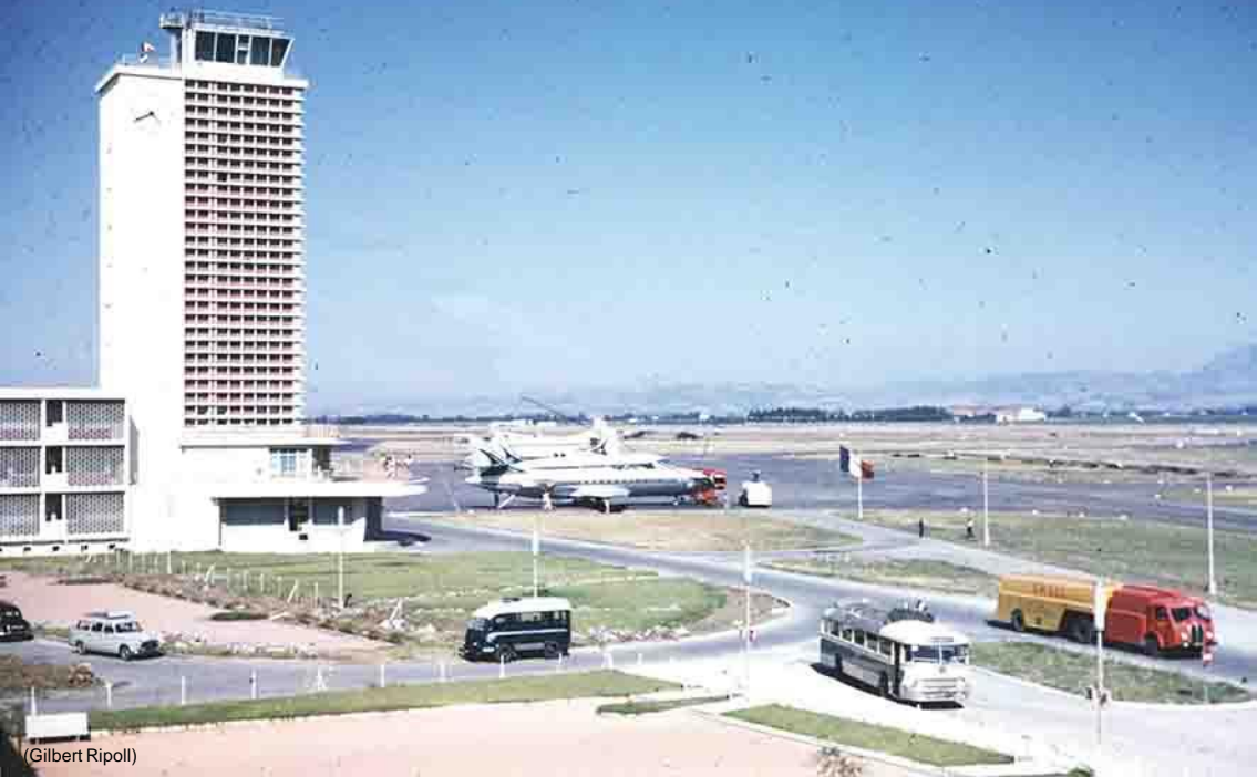
La tour de contrôle et son horloge
