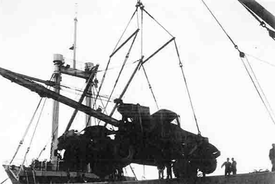
Embarquement à Bône, pour Alger, après la fin des travaux en 1956
